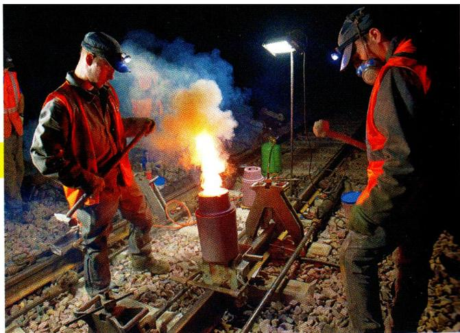
**Fig. 2** Production de fer pour souder un rail.
